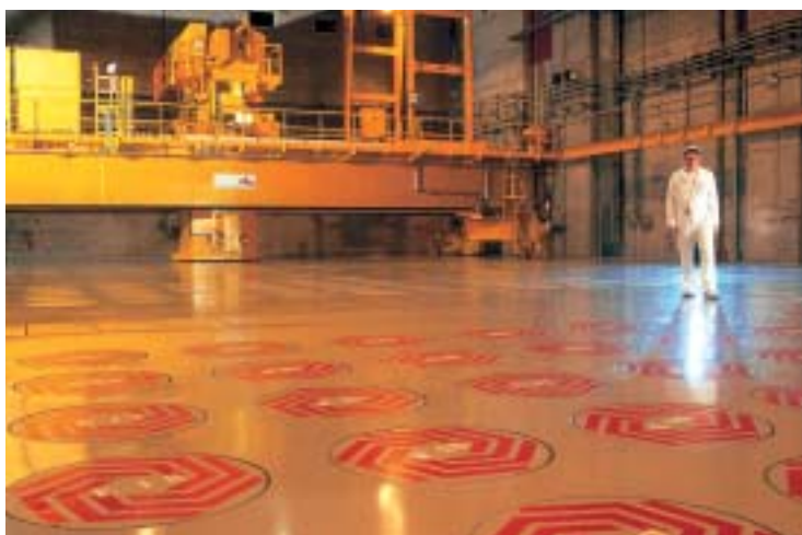
Fig. 21. Entreposage de déchets vitrifiés sur le site de COGEMA La Hague (Manche).
