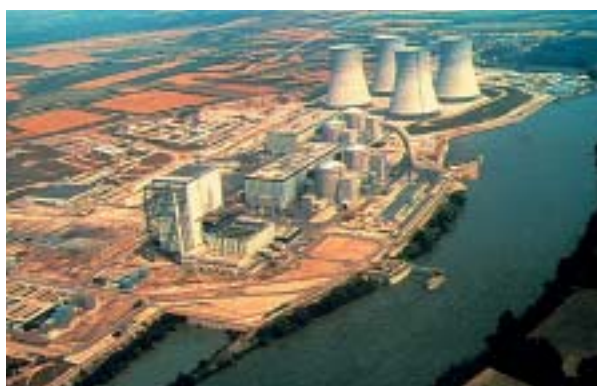
Fig.85. Des réacteurs de 1 re génération à ceux de 2 e génération : on voit le gros réacteur UNGG (arrêté) et les petits REP (en service) qui lui ont succédé sur le site du Bugey (Ain).
