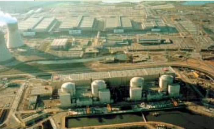
Fig. 17. L'usine d'enrichissement Georges Besse, à Pierrelatte (Drôme).
