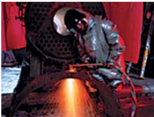
Fig. 25. Découpe d'une chaudière auxiliaire en combinaison ventilée ignifugée.
