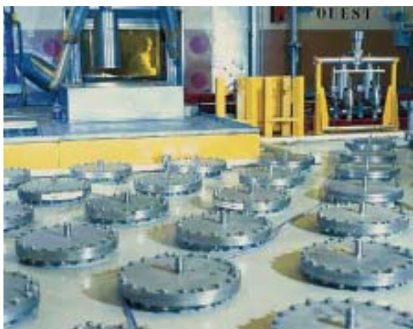
Fig. 73. Partie haute des puits d'entreposage de l'installation CAS-CAD à Cadarache (Bouches-du-Rhône).
