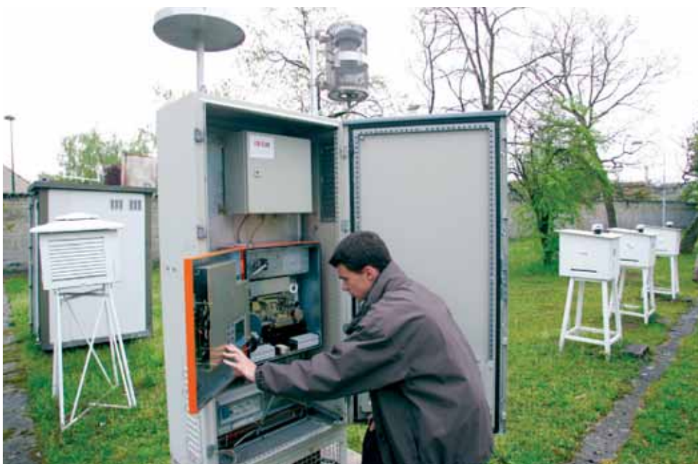
Intérieur d'une balise SARA (surveillance des aérosols).
